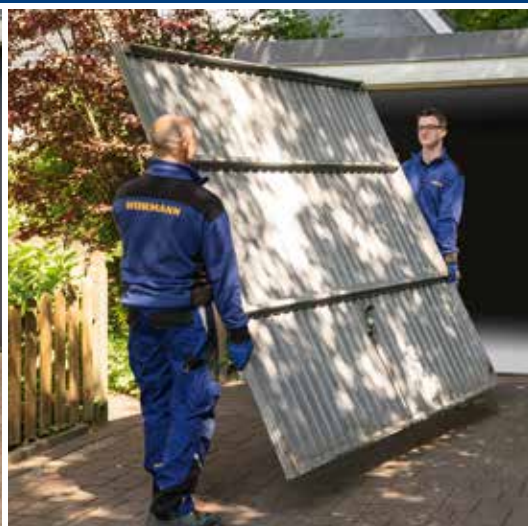
Demontaż i ekologiczna utylizacja
